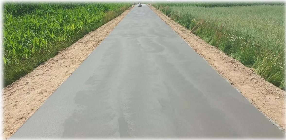
Zdjęcie nr 3. Przebudowa drogi gminnej w m. Popławy
