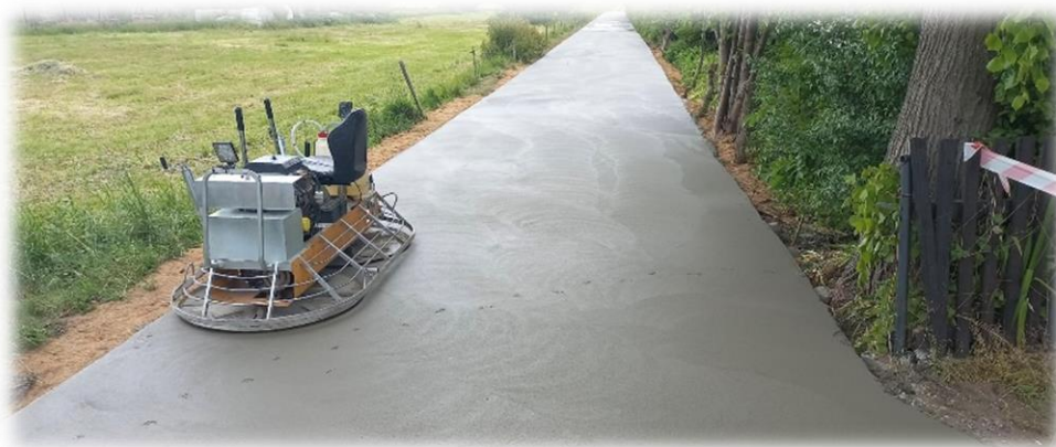
Zdjęcie nr 2. Przebudowa ciągu pieszego w m. Puchały Stare
