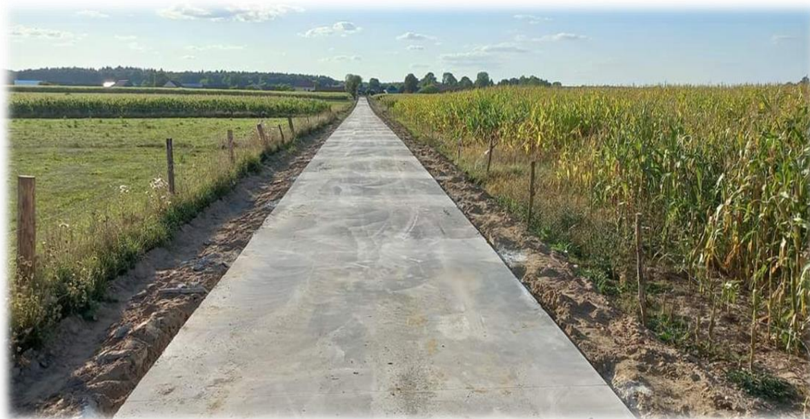
Zdjęcie nr 4. Przebudowa drogi gminnej w m. Poletyły
