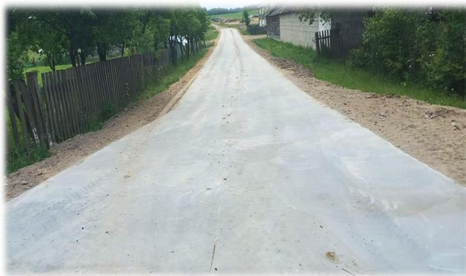
Zdjęcie nr 1. Przebudowa drogi gminnej w m. Załuskie Koronne
